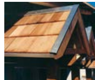
Détail bardeaux bois
