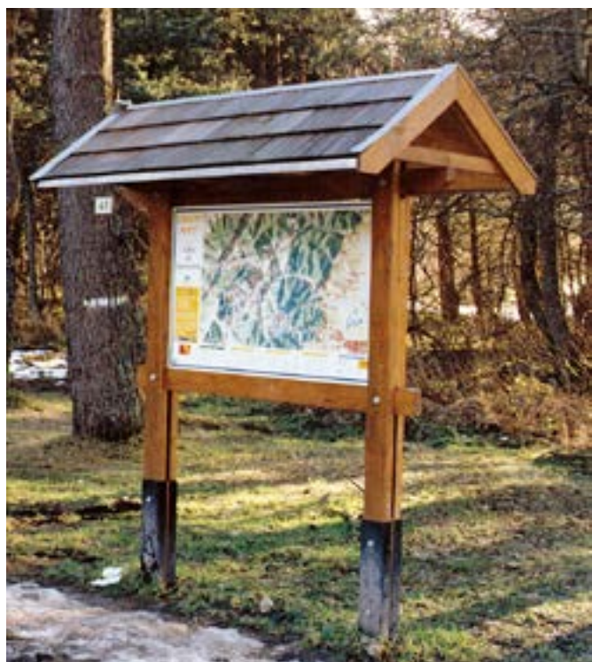
Mobilier toiture 2 pans couverture bardeaux bois
