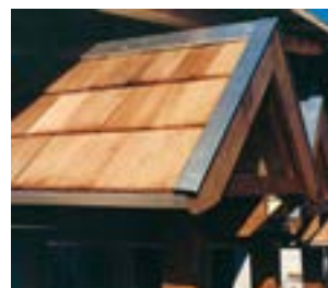
Détail bardeaux bois
