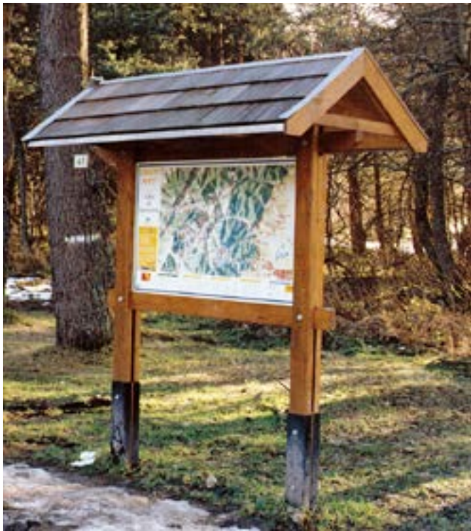
Mobilier toiture 2 pans couverture bardeaux bois
