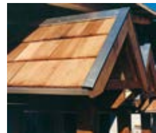
Détail bardeaux bois
