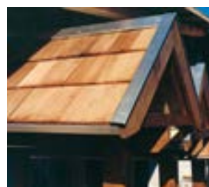
Détail bardeaux bois
