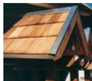
Détail bardeaux bois
